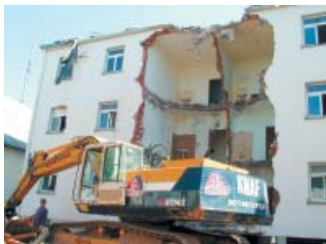
Der Abriß ist in vollem Gange
