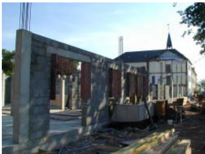
Der Aufbau ist in vollem Gange
